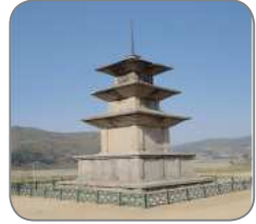
감은사지 3층 석탑
